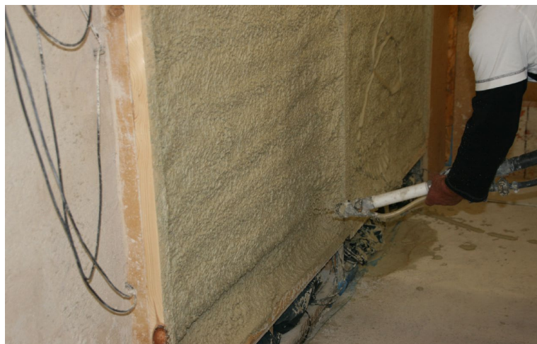
Abb. 10 Verarbeitung des Dämmputzes im Prüfstand
